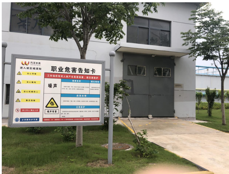
图 4.1.3-1 风机房现场噪声标识
