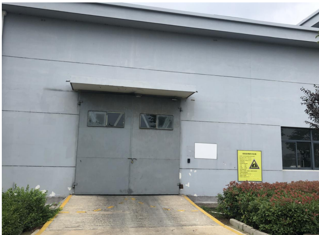
图 4.1.4-1 危废暂存库外部
