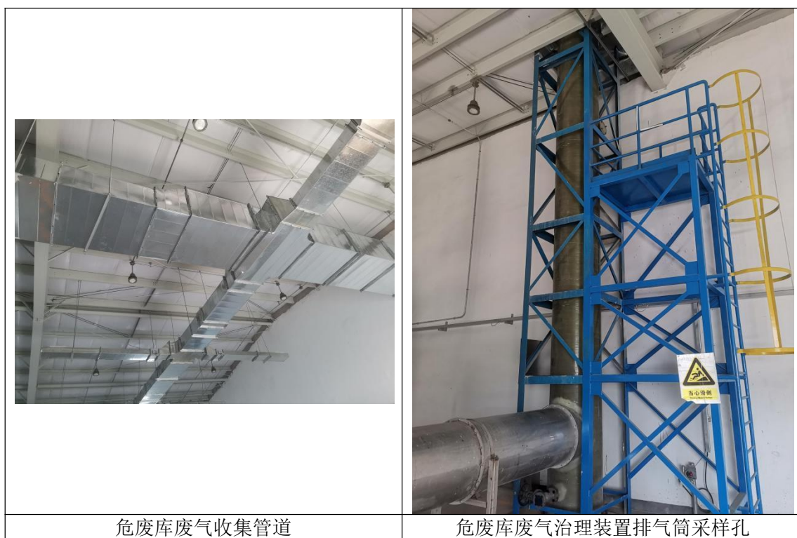
图 6.5.1-1 连云港石化有限公司现有危废库
