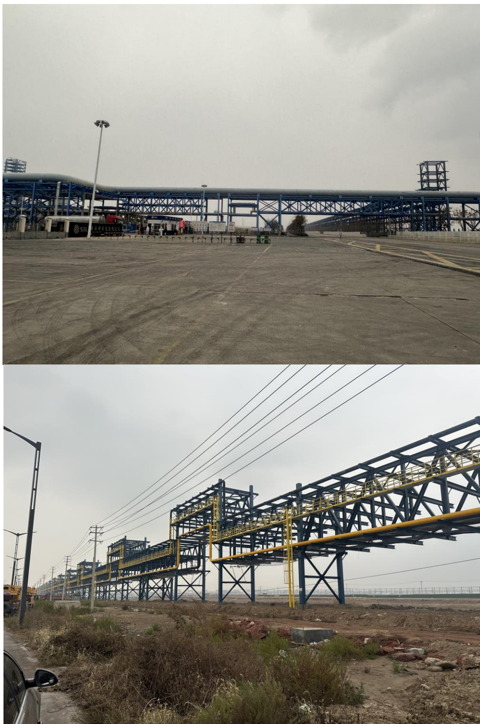
图 2-1 园区现有管廊现状照片
