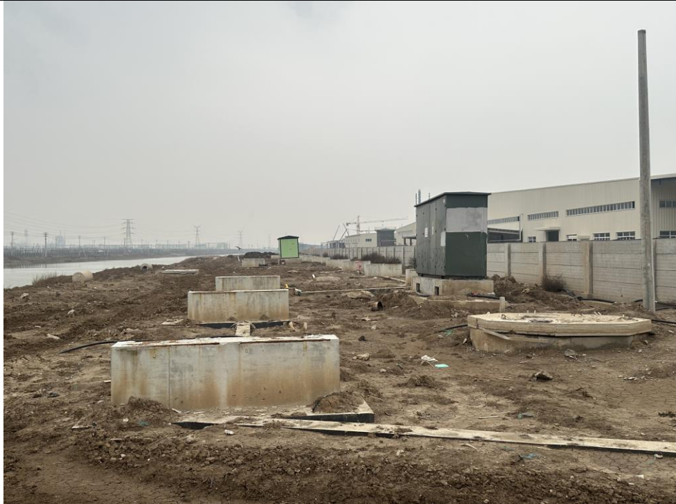
图 2-2 卫星绿色材料厂区北侧现状照片（图中管墩为蒸汽管墩）
