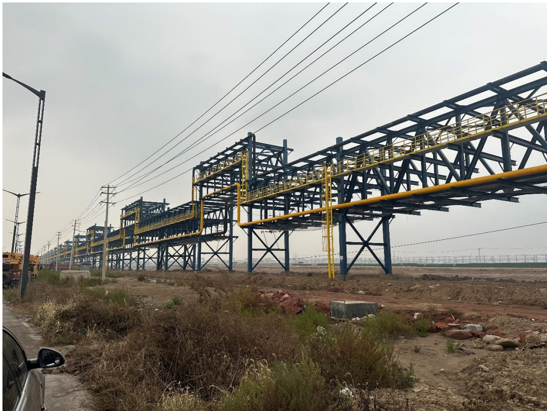
公共管廊现状情况
